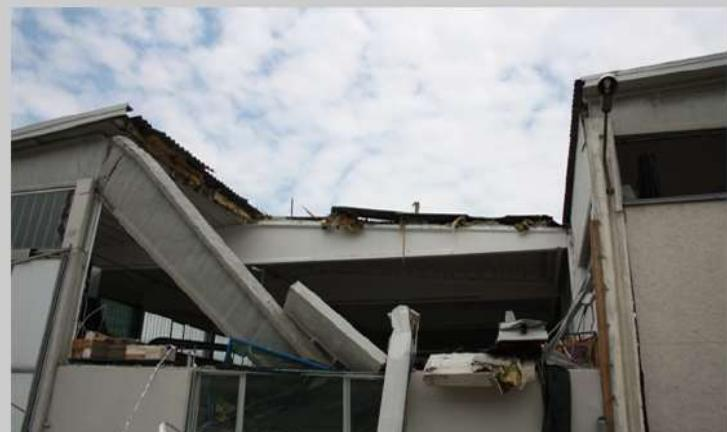
Perdita d'appoggio della trave principale in un edificio monopiano prefabbricato.
