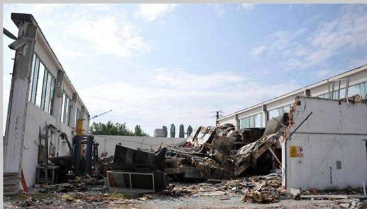
Crollo della copertura causato dalla perdita di appoggio degli elementi portanti.
